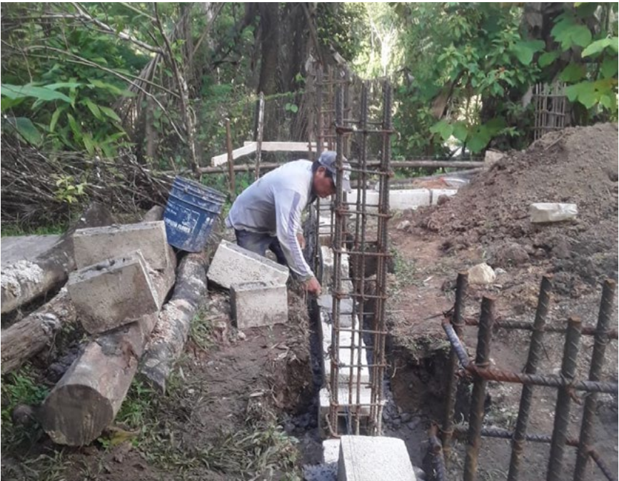
Caralampio colocando block para recibir la cadena. Fotografía: Equipo de Loma Bonita.
