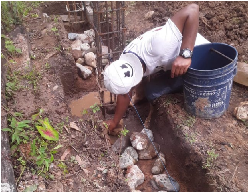
Neysler colocando la piedra para la cimentación. Fotografía: Equipo de Loma Bonita.
