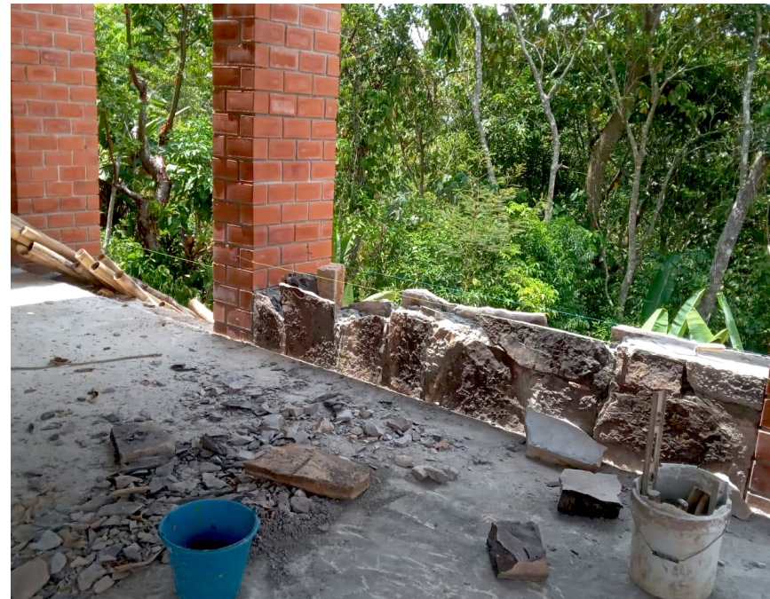
Mano de obra pagada: Construcción de rodapiés con piedra laja. Foto: Cuadrilla local.
